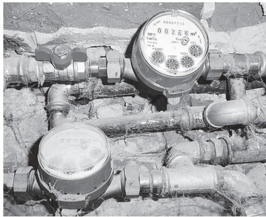
Счетчики горячего и холодного водоснабжения
