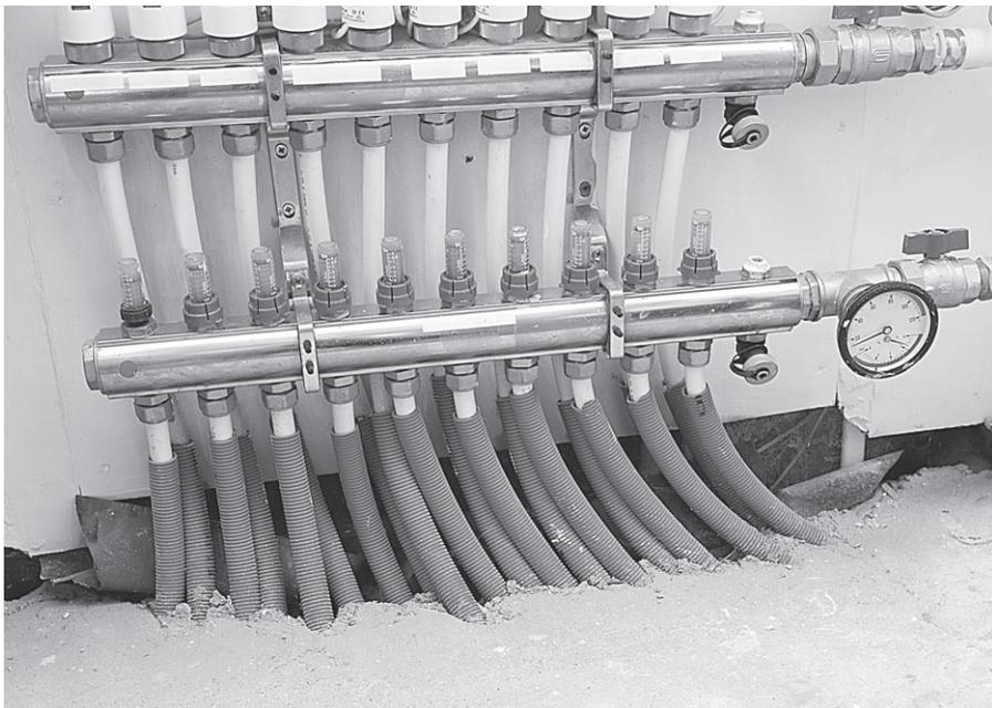
**Готовая стяжка и распределительная система теплого пола**
