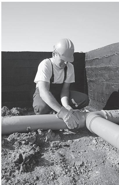
**Раструбное соединение чаще используется в системах канализации**
