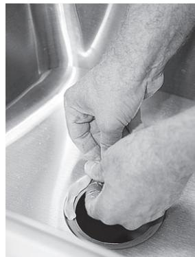
Использование пластикового герметика на полимерной основе
