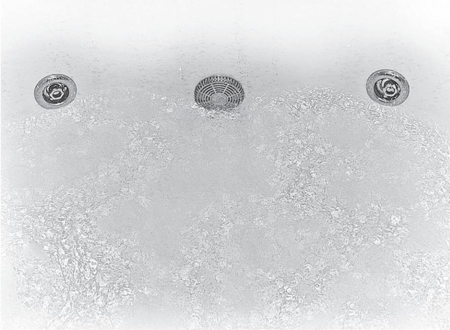
**Водозаборник (в центре) и гидромассажные форсунки (справа и слева)**
