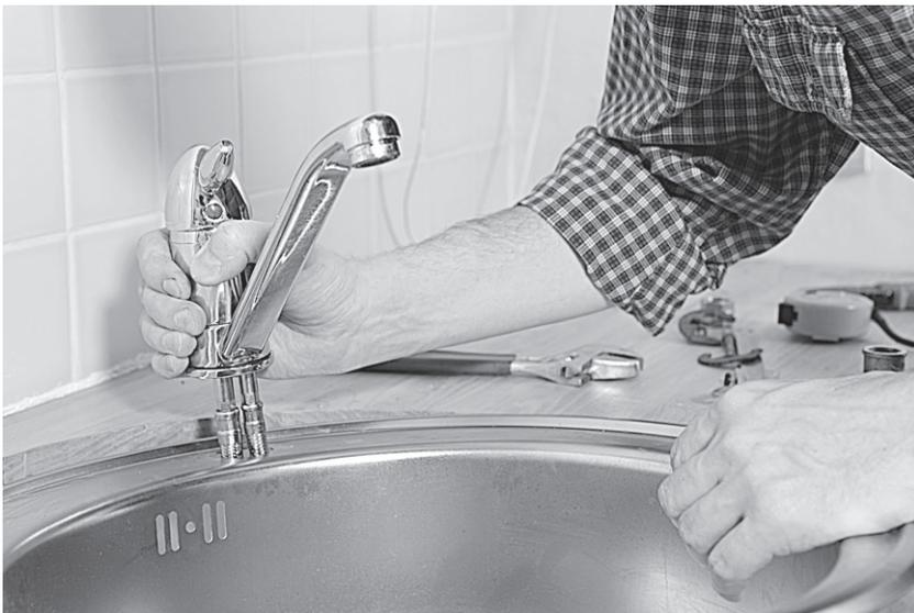
Демонтаж старого смесителя на узкой основе
